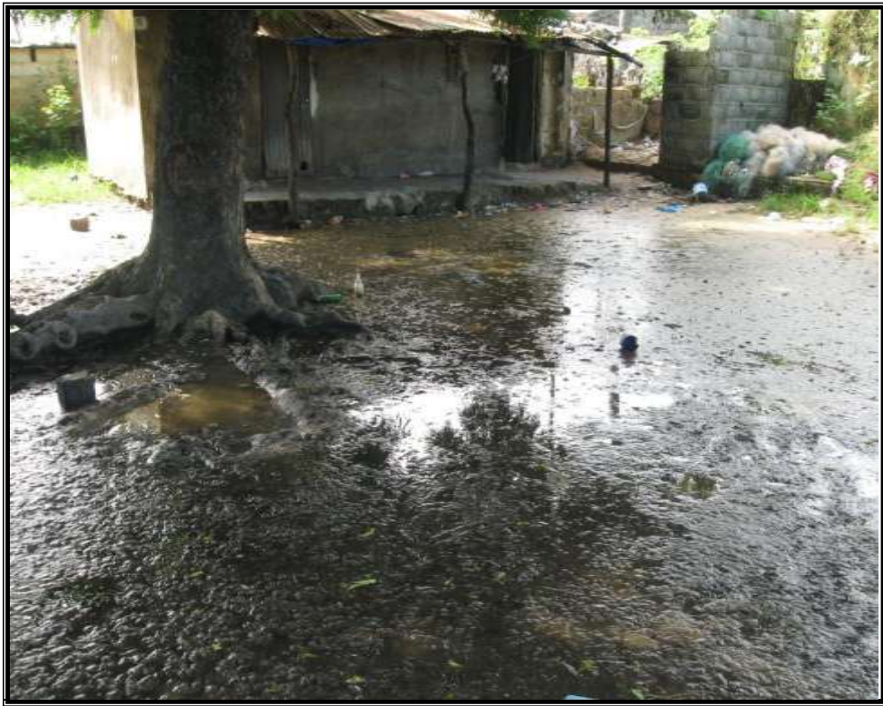
Photo 1 : Maison abandonnée à cause de l'humidité du sol après la pluie à Belfort en août 2024
