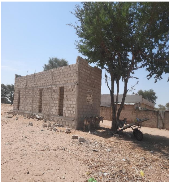
Photo 2 : acacia à côté d'un bâtiment en chantier
