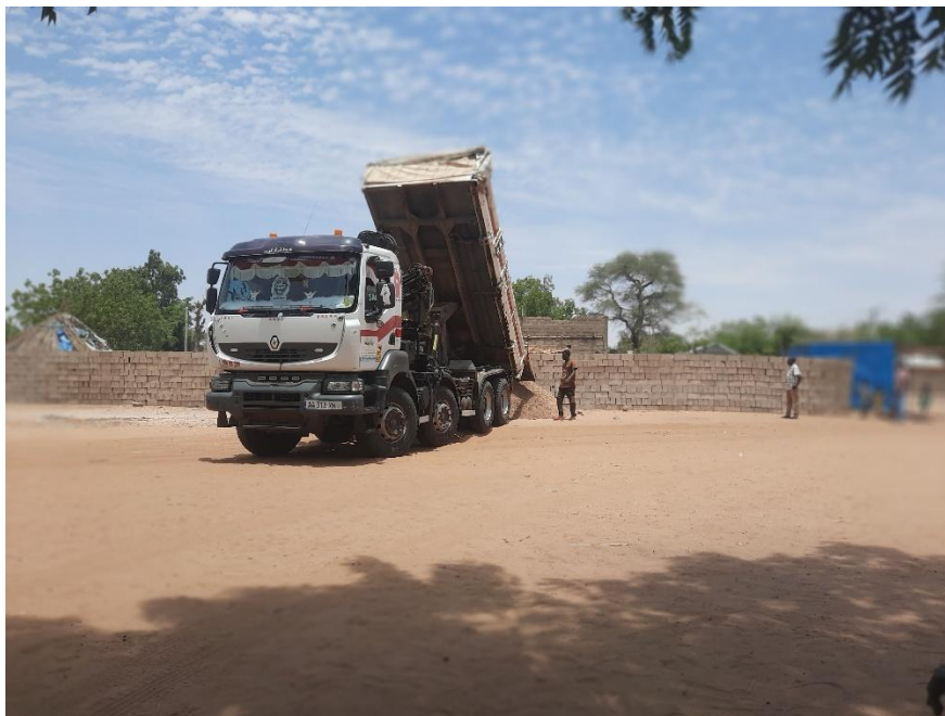
Photo 3 : camion benne déchargeant 20 m 3 de sable
