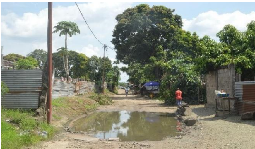
Photo 2 : Les eaux de pluies dans un nids-de-poule
