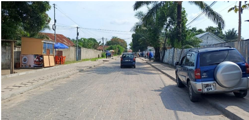
Photo 3 : Avenue BERNARD THIBAMBELLELA aménagée en pavés
