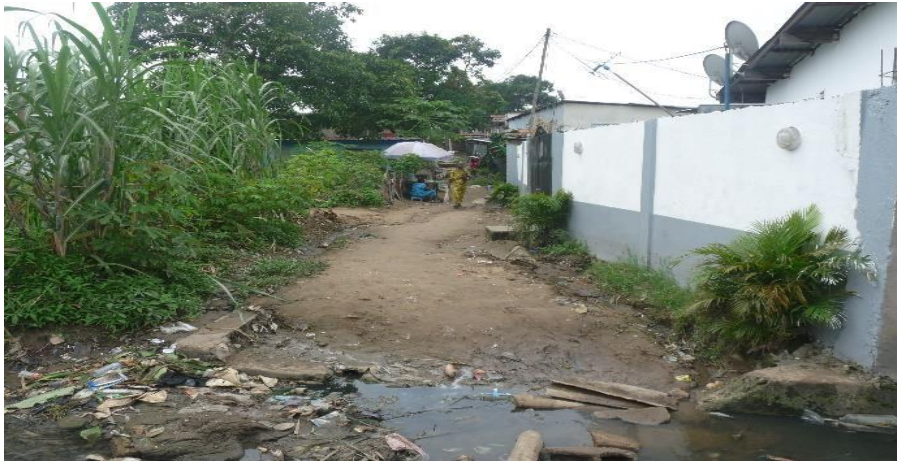
Photo 1 : Une voie d'accessibilité réduite
