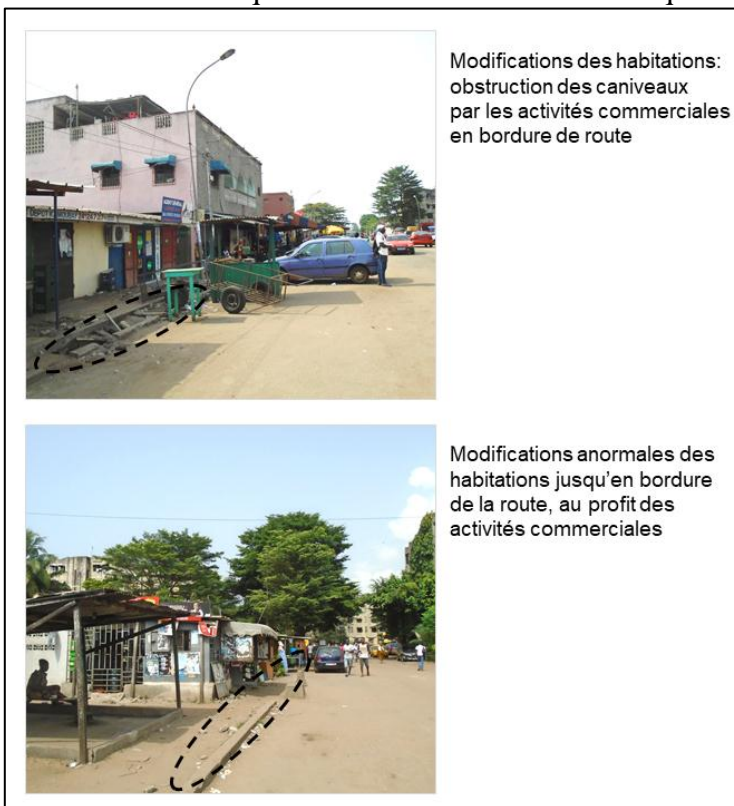
Figure 3 : Anarchie urbaine : modifications des habitations et activités économiques obstruant les caniveaux au quartier Océan
