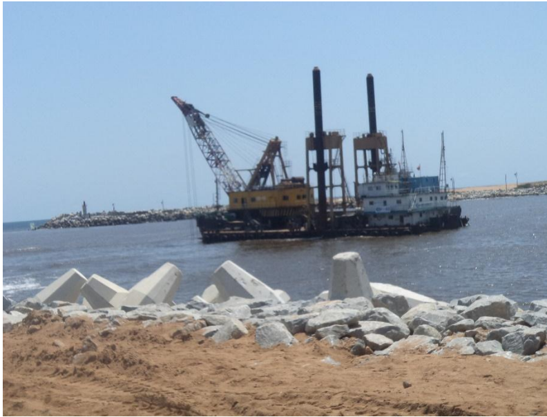
Photo 3 : travaux en cours au canal de Vridi
