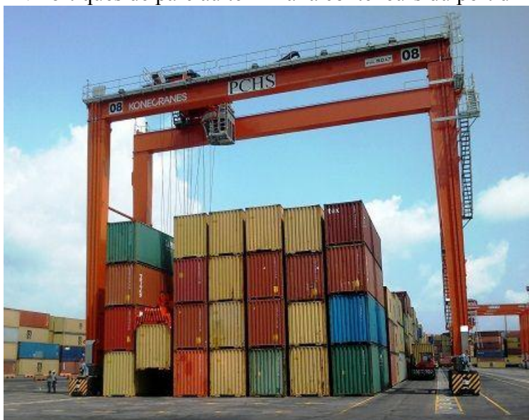
Photo 2 : Portiques de parc au terminal à conteneurs du port d'Abidjan
