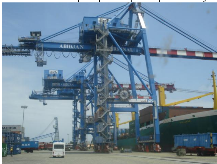
Photo 1 : Vue des portiques de quai au port d'Abidjan
