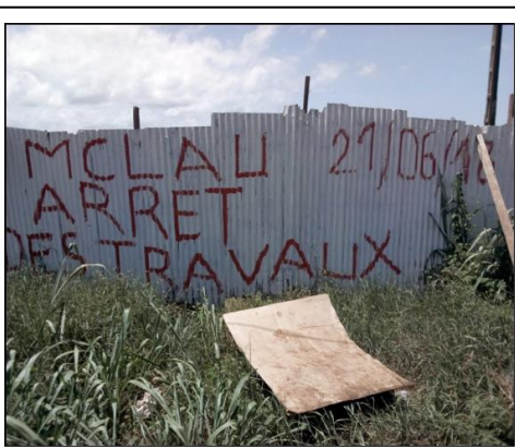
Photo IV : Arrêt des travaux de construction demandé par les autorités locales (Sonouko)
