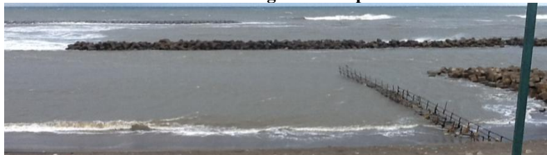
Photo 6 : Canal de dérivation du Shinano river à Hokuriku Préfecture de Kanagawa au Japon
