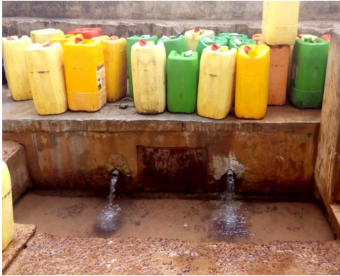
Photo 3 : Source d'eau aménagée à Gbokora
