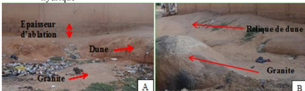
Photo 1. Prédisposition structurale des batis aux dommages liés à l'érosion hydrique
