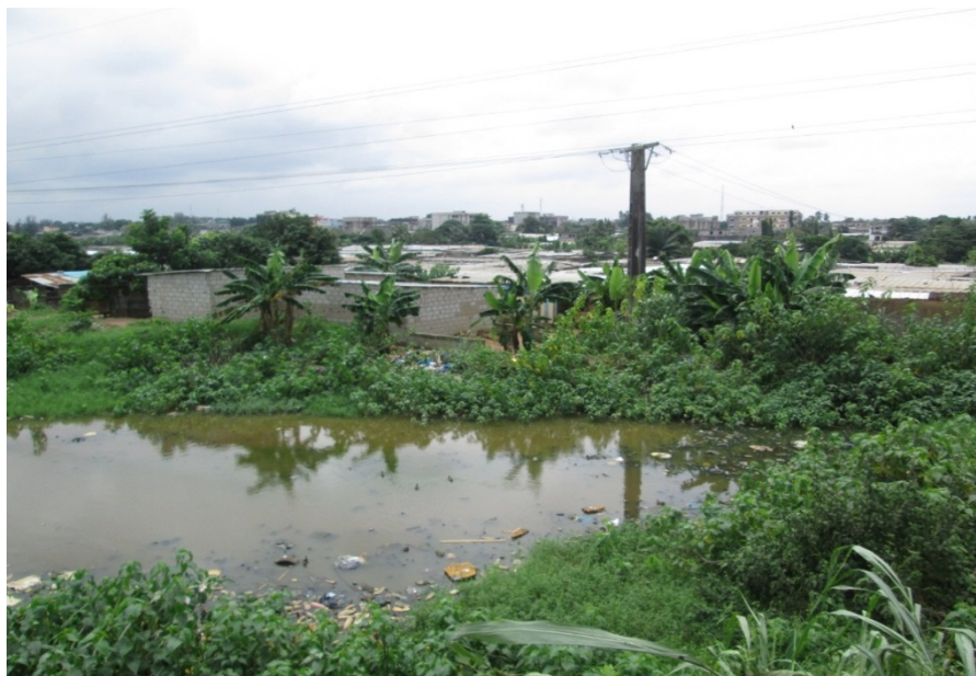
Photo 1 : Stagnation des eaux pluviales et vannes à Gobelet
